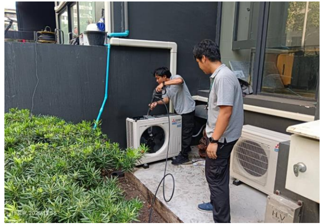
รูปที่ 2-28 เจ้าหน้าที่ทำความสะอาดแอร์ส่วนกลาง
