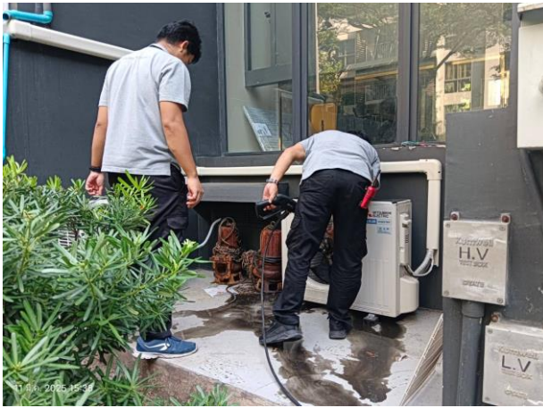
รูปที่ 2-28 เจ้าหน้าที่ทำความสะอาดแอร์ส่วนกลาง
