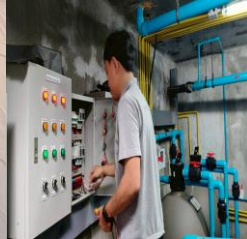
ตรวจสอบและทำความสะอาดปั๊มสระว่ายน้ำ
