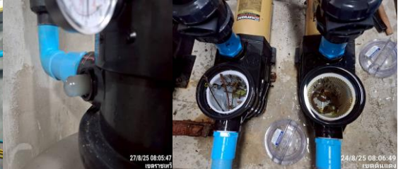
ตรวจสอบและทำความสะอาดปั๊มสระว่ายน้ำ
